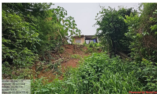
Monitoramento de áreas com risco de deslizamento
