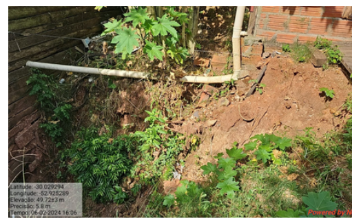
Monitoramento de áreas com risco de deslizamento
