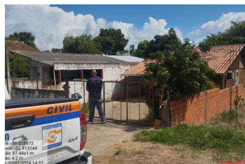
Vistoria de áreas de risco para processos judiciais
