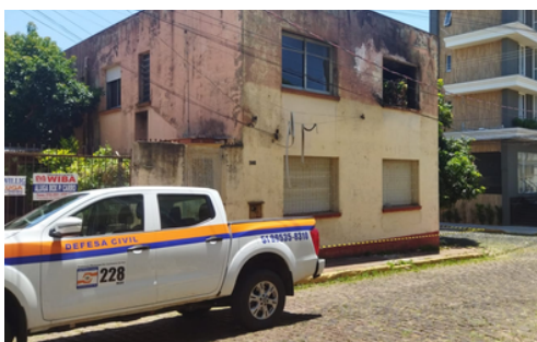
Isolamento de passeio público área de risco de acidentes
