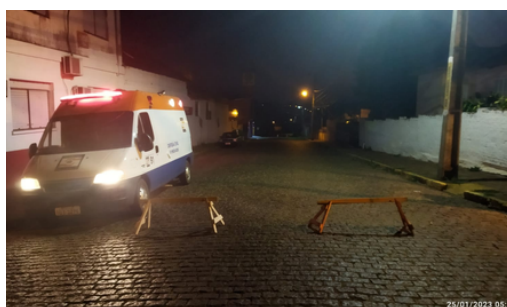
Isolamento de via pública, rompimento de rede.
