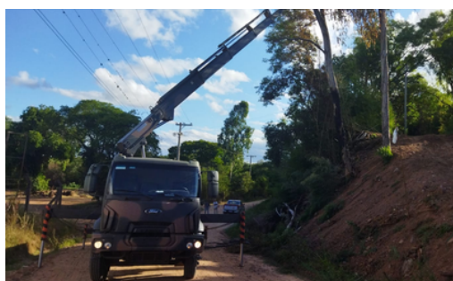
Manejo de árvores com risco de queda sobre a rede de energia.
